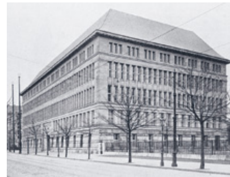
Ehemalige Mannesmann-Hauptverwaltung Düsseldorf, 1911 – 1912. Abb.: Julius Söhn, Bildarchiv Foto Marburg
