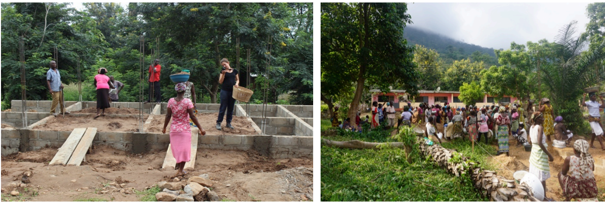
Abb: Zusammenarbeit mit der Dorfgemeinschaft: Dorfgemeinschaft hilft beim Auffüllen der Fundamente
