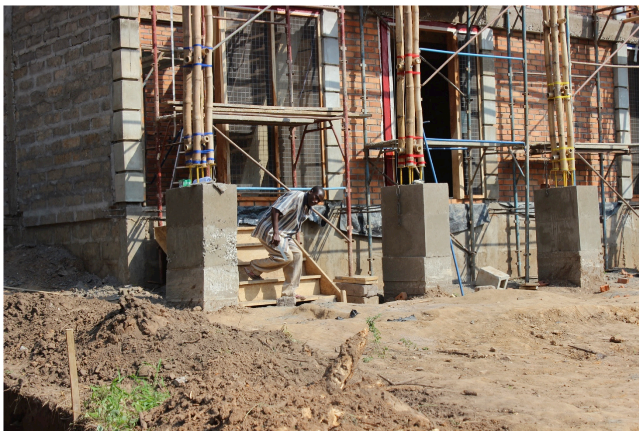
Abb: Baustelle - Stützen experimentelles Bambustragwerk
