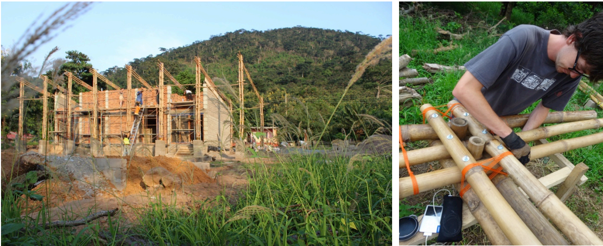
Abb: Baustelle mit experimentellem Bambustragwerk für Sonnenschutzdach/ Bambusknoten Dachtragwerk
