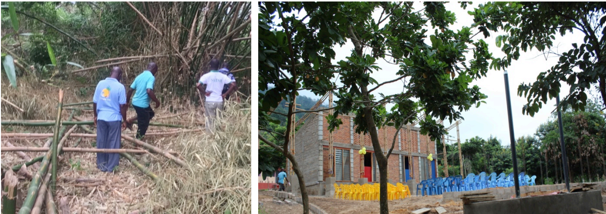
Abb: Bambusschlagen/ Richtfest des ersten Gebäudeteiles
