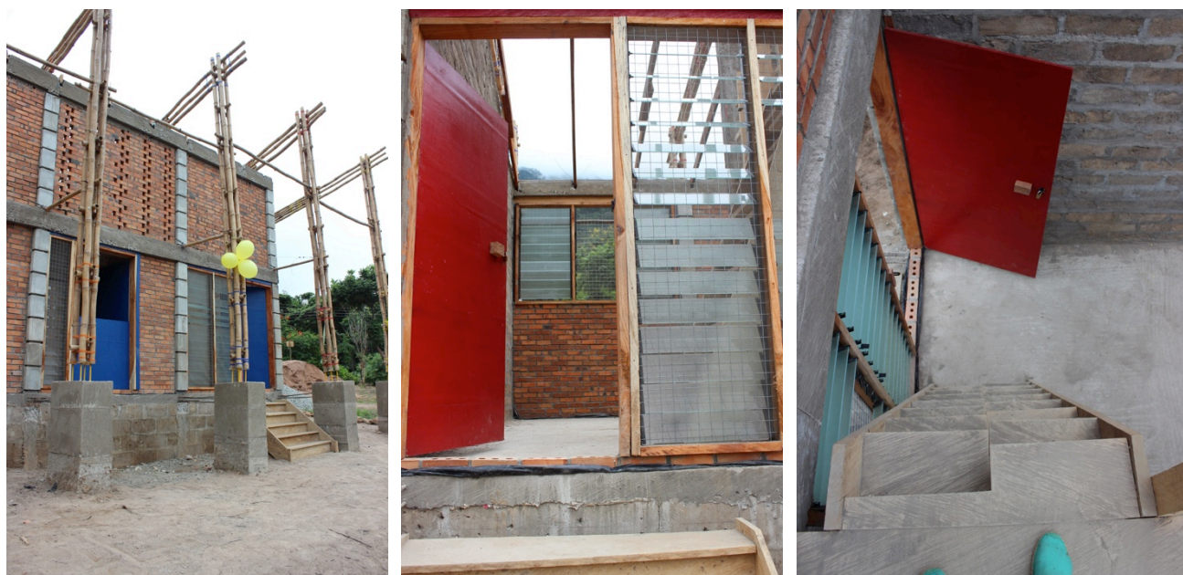
Abb: fertiger Gebäudeteil noch ohne Dach/ Eingang/ Treppe zur Empore
